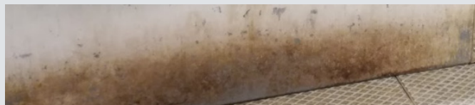
Categoría 3 - Contaminación por cal hidratada
