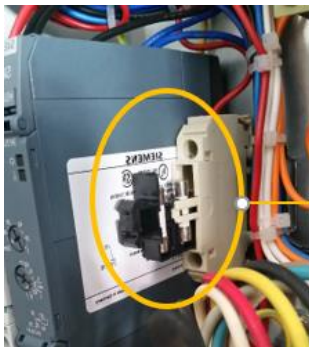
Sicherung herausziehen
