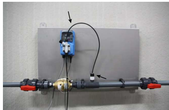
Imagen 4: Conectar tubo flexible presión
