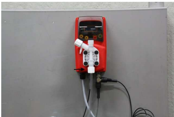
Imagen 7: Conectar tubo flexible aspiración
