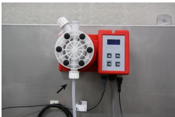
Figura 3: Collegare il tubo di aspirazione
