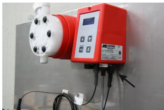
Figura 2: Collegare la protezione contro il funzionamento a secco
