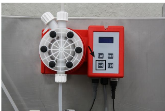
Figur 5: Tænd for pumpen
