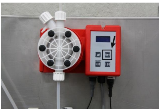
III. 8: Remplir la tubulure de sortie
