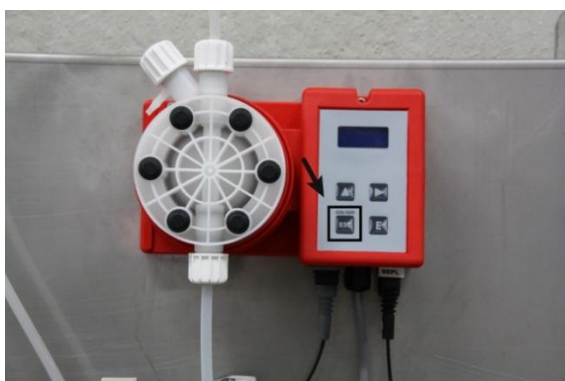
III. 5: Mettre la pompe sous tension
