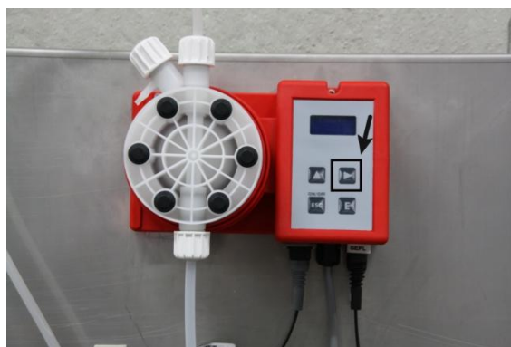
Imagen 8: Llenar el conducto de presión
