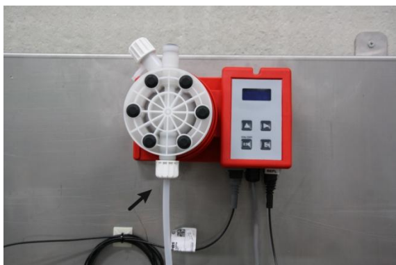
Figura 3: Collegare il tubo di aspirazione
