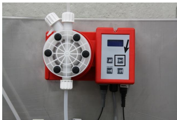
Figura 8: Riempire il condotto in pressione
