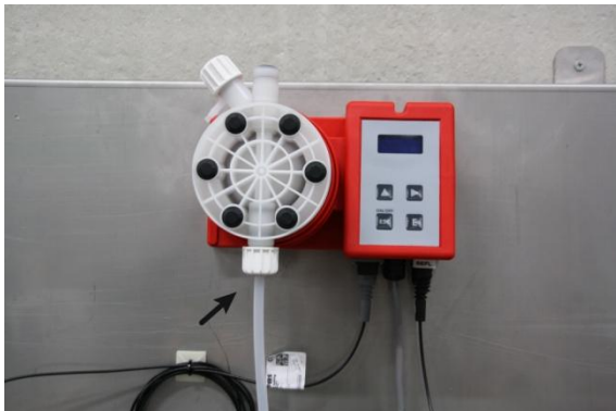
III. 3: Raccorder le tuyau d'arrivée
