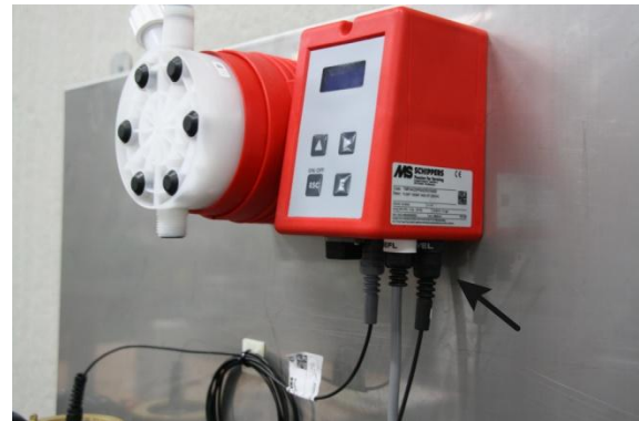
III. 2: Raccorder la sécurité anti assèchement
