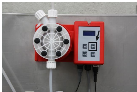
III. 8: Remplir la tubulure de sortie
