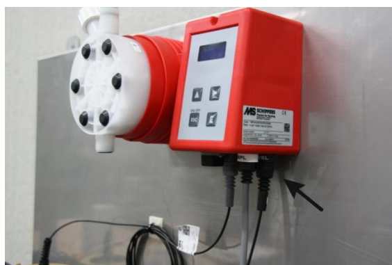
Figur 2: Tilslut tørkøbsbeskyttelsen og vandmåleren.
