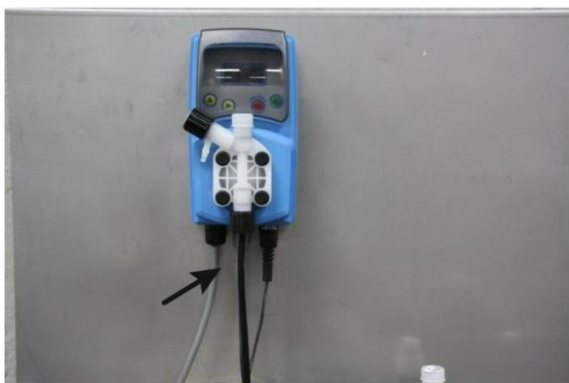
Figur 3: Tilkobl sugeslangen
