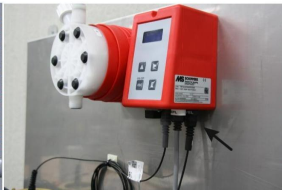
Figur 6: Tilslut tørkøringsbeskyttelsen
