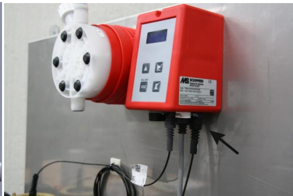
Figura 6: Collegare la protezione contro il
