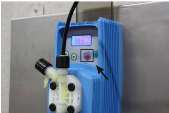
Figura 9: Avviare la pompa
