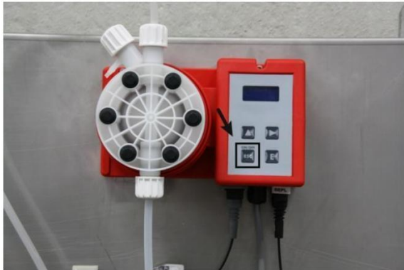
Ill. 13: Mettre la pompe sous tension
