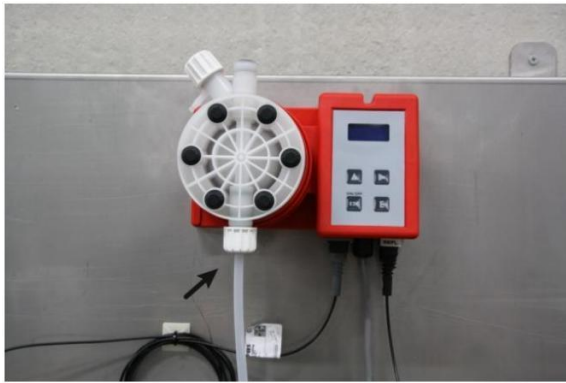
Ill. 7: Raccorder le tuyau d'arrivée
