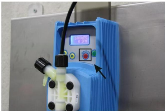
Ill. 9: Mettre la pompe sous tension
