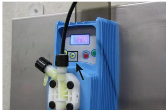
Ill. 12: Remplir la tubulure de sortie
