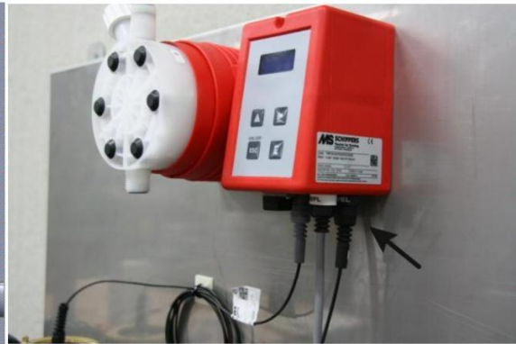
Abbildung 6: Trockenlaufschutz anschließen
