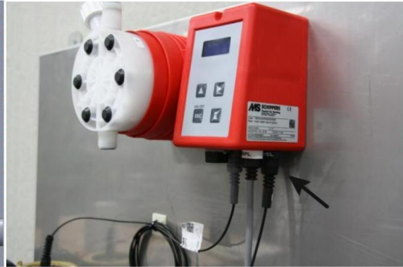
III. 6: Raccorder la sécurité anti assèchement
