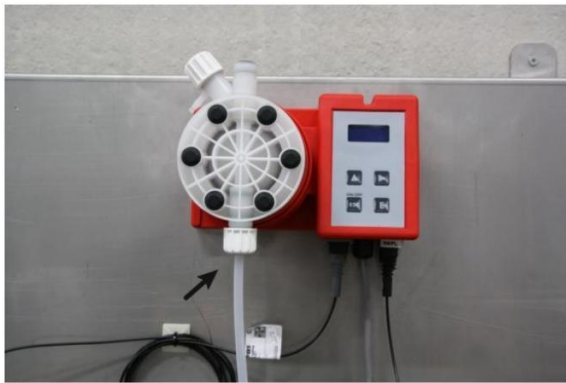
III. 7: Raccorder le tuyau d'arrivée
