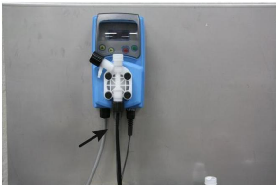
III. 3: Raccorder le tuyau d'arrivée
