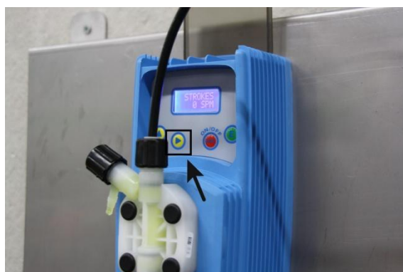
Imagen 12: Llenar el conducto de presión
