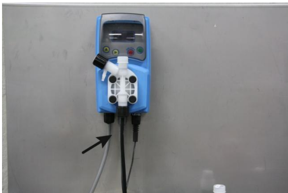
Imagen 3: Conectar tubo flexible aspiración
