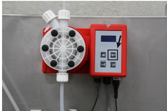
Imagen 16: Llenar el conducto de presión
