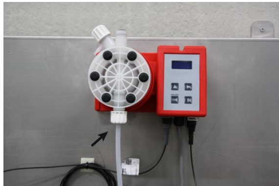
Imagen 7: Conectar tubo flexible aspiración
