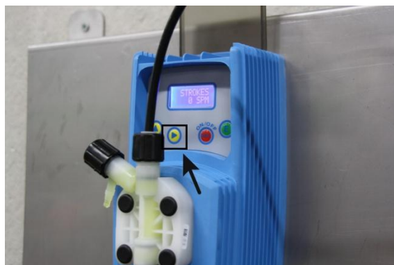
Figura 12: Riempire il condotto in pressione
