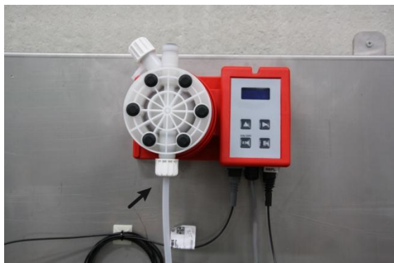
Figura 7: Collegare il tubo di aspirazione
