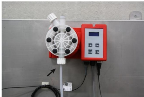
Figur 7: Tilknytning af sugeslangen
