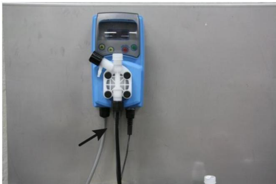
Figur 3: Tilkobl sugeslangen
