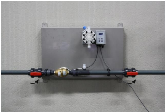
Abbildung 1: Kugelventile öffnen
