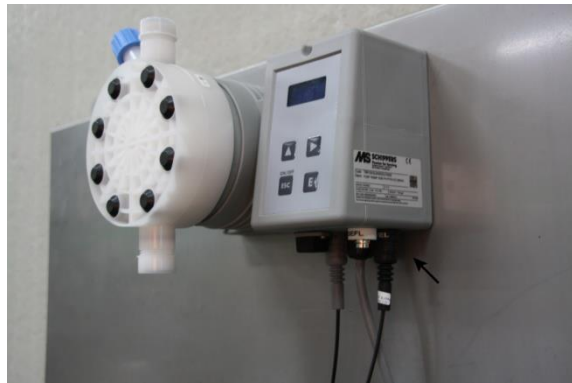
Abbildung 2: Trockenlaufschutz anschließen
