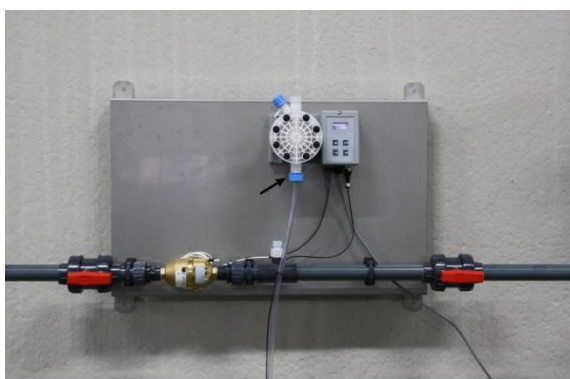
III. 3: Raccorder le tuyau d'arrivée
