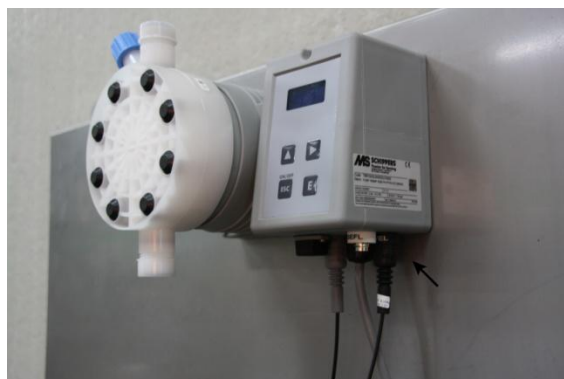
III. 2: Raccorder la sécurité anti assèchement
