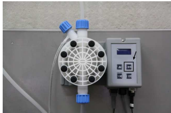
Figura 8: Riempire il condotto in pressione
