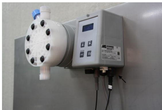
Figur 2: Monter lyddæmperen
