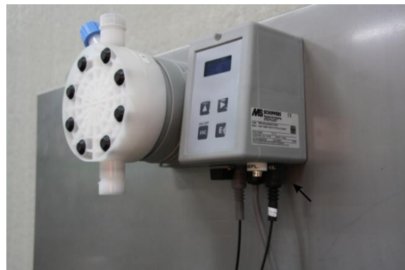
Afbeelding 2: Aansluiten droogloopbeveiliging en waterteller
