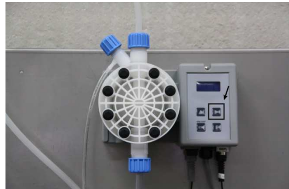
Imagen 8: Llenar el conducto de presión
