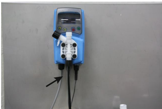
Afbeelding 3: Aansluiten aanzuigslang
