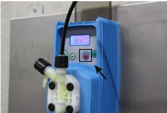
Afbeelding 5: Aanzetten van de pomp
