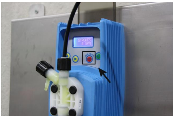
Figura 5: Avviare la pompa
