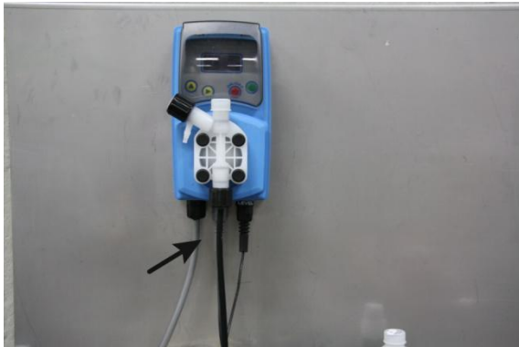
Figura 3: Collegare il tubo di aspirazione
