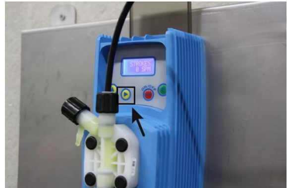
Imagen 8: Llenar el conducto de presión
