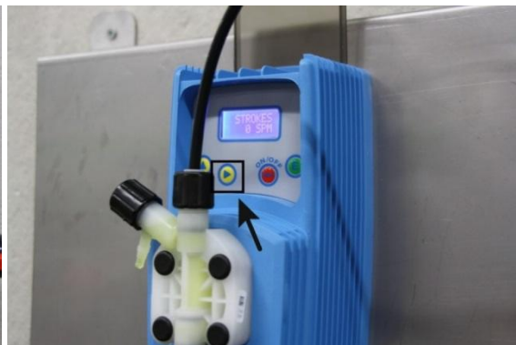
III. 12: Remplir la tubulure de sortie
