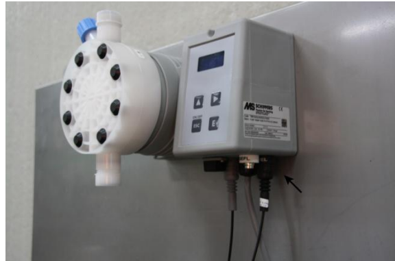
III. 6: Raccorder la sécurité anti assèchement
