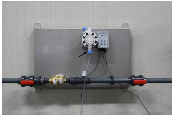
III. 7: Raccorder le tuyau d'arrivée
