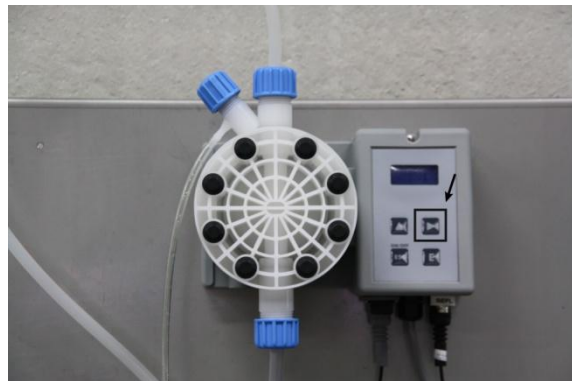
III. 16: Remplir la tubulure de sortie
