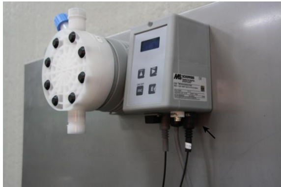
Abbildung 6: Trockenlaufschutz anschließen
