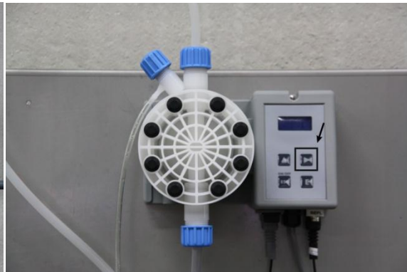
Abbildung 16: Druckluftschlauch befüllen
