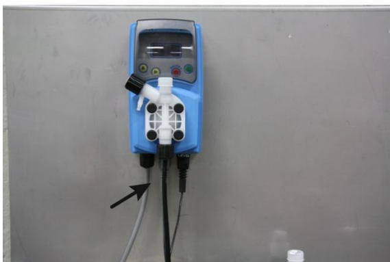
Imagen 3: Conectar tubo flexible aspiración
