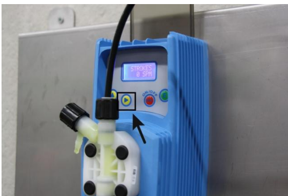
Imagen 8: Llenar el conducto de presión
