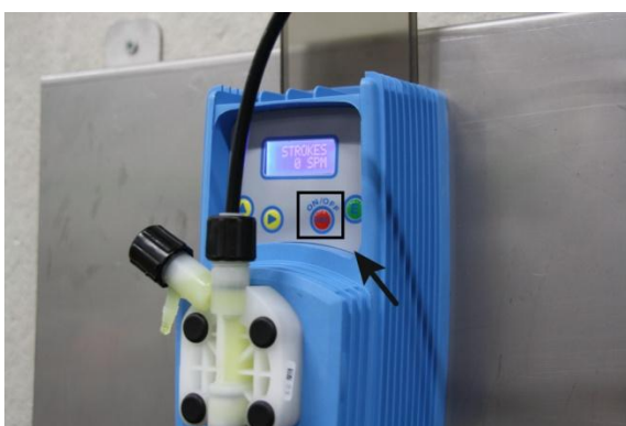
Figur 5: Tænd for pumpen
