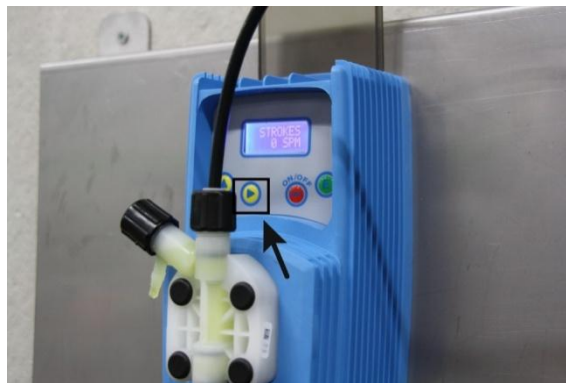
Figura 8: Riempire il condotto in pressione
