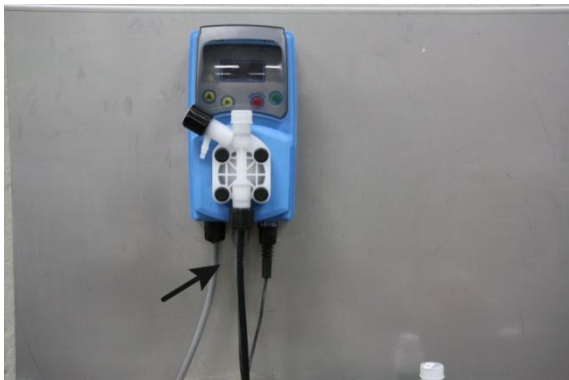
Afbeelding 3: Aansluiten aanzuigslang
