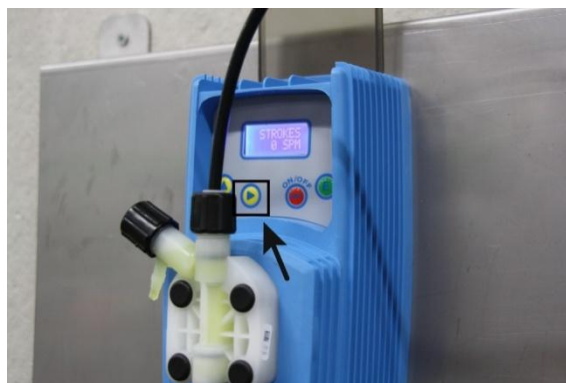
Imagen 8: Llenar el conducto de presión
