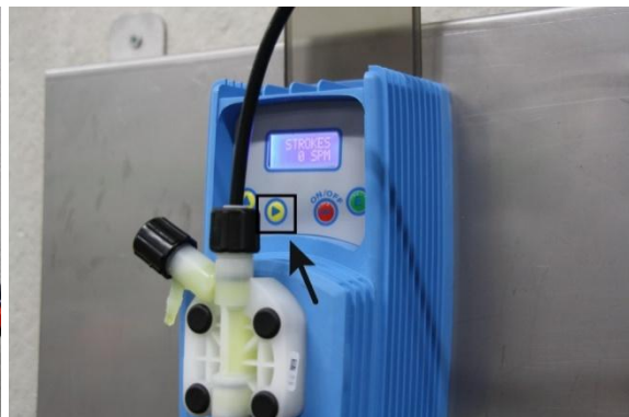
III. 8: Remplir la tubulure de sortie
