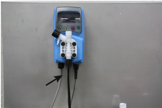
III. 3: Raccorder le tuyau d'arrivée
