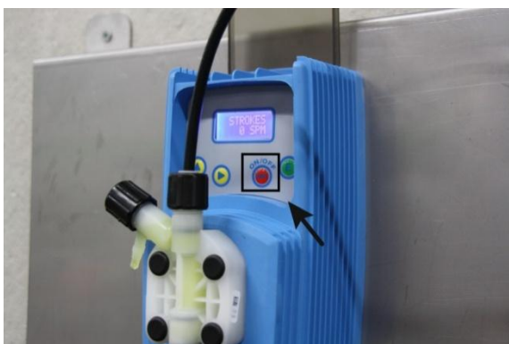
Figur 5: Tænd for pumpen
