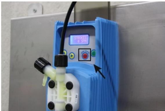
Abbildung 5: Pumpe einschalten
