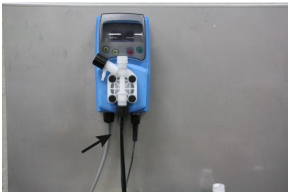
Figura 3: Collegare il tubo di aspirazione
