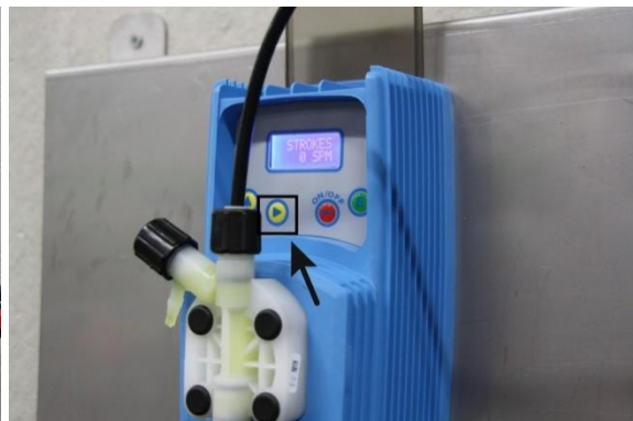
III. 8: Remplir la tubulure de sortie
