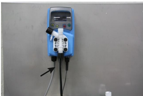
Imagen 3: Conectar tubo flexible aspiración
