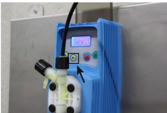
Imagen 8: Llenar el conducto de presión
