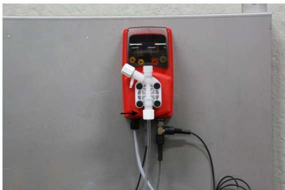
Figur 3: Tilkobl sugeslangen
