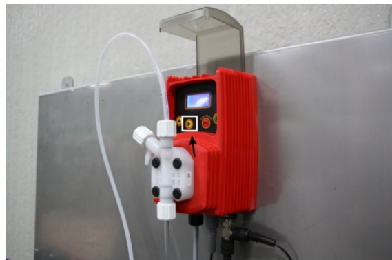
III. 8: Remplir la tubulure de sortie
