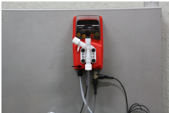
Figura 3: Collegare il tubo di aspirazione
