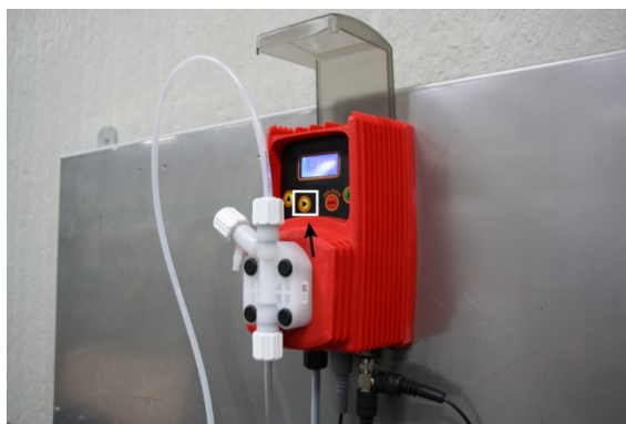
Figura 8: Riempire il condotto in pressione
