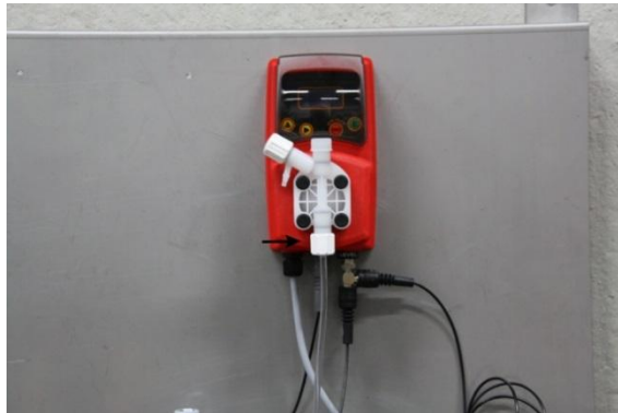
III. 6: Raccorder le tuyau d'arrivée
