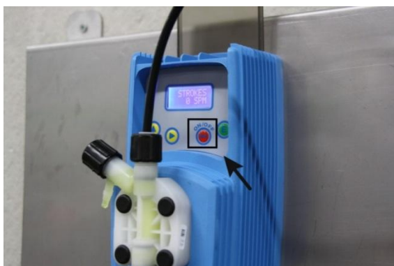
III. 8: Mettre la pompe sous tension
