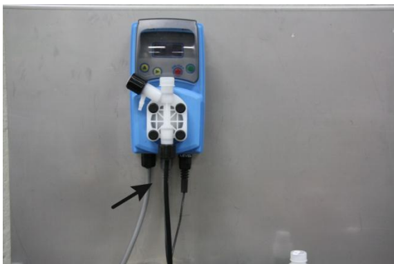
Figur 3: Tilkobl sugeslangen
