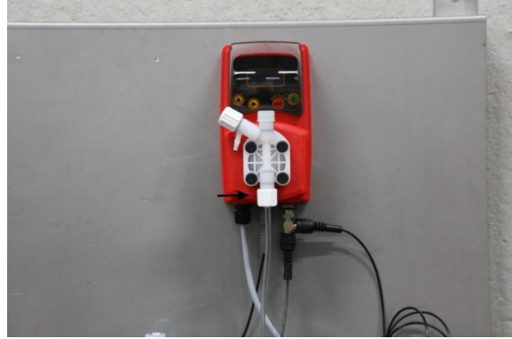
Figur 6: Tilkobl sugeslangen
