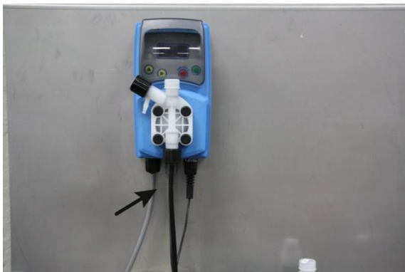
Abbildung 3: Saugschlauch anschließen
