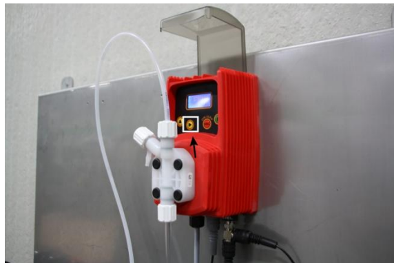
Figura 15: Riempire il condotto in pressione
