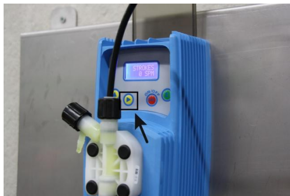
Figura 11: Riempire il condotto in pressione
