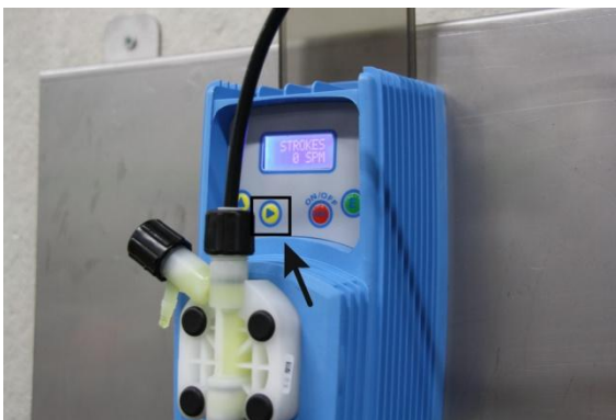
Imagen 11: Llenar el conducto de presión
