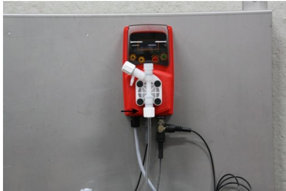
Imagen 6: Conectar tubo flexible aspiración
