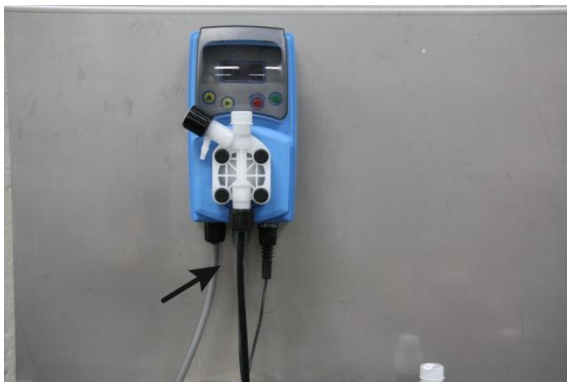
Imagen 3: Conectar tubo flexible aspiración
