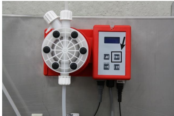
Abbildung 15: Druckluftschlauch befüllen
