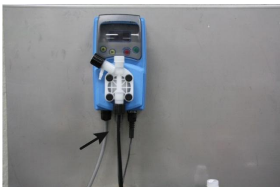
III. 3: Raccorder le tuyau d'arrivée
