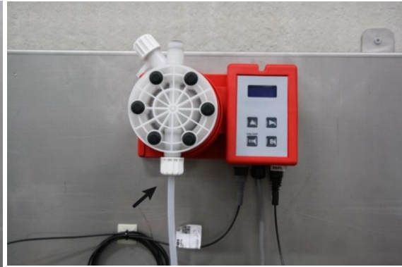
III. 6: Raccorder le tuyau d'arrivée
