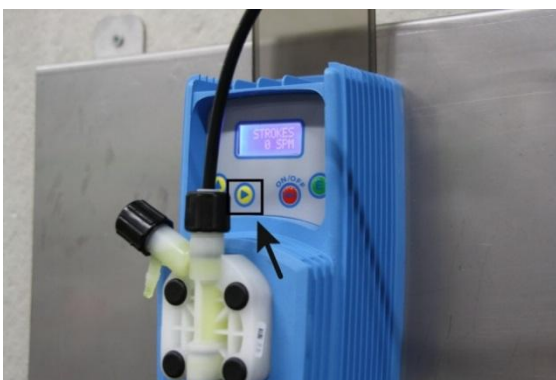
III. 11: Remplir la tubulure de sortie
