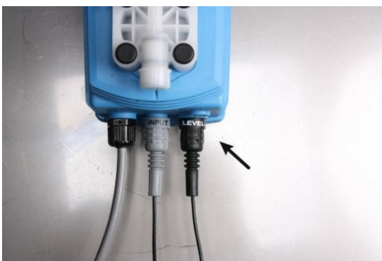
III. 2: Raccorder la sécurité anti assèchement
