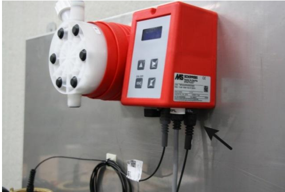
III. 5: Raccorder la sécurité anti assèchement
