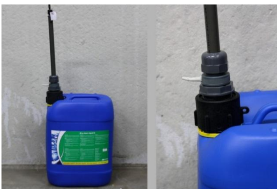
III. 9: Placer lance d'arrivée sur le réservoir
